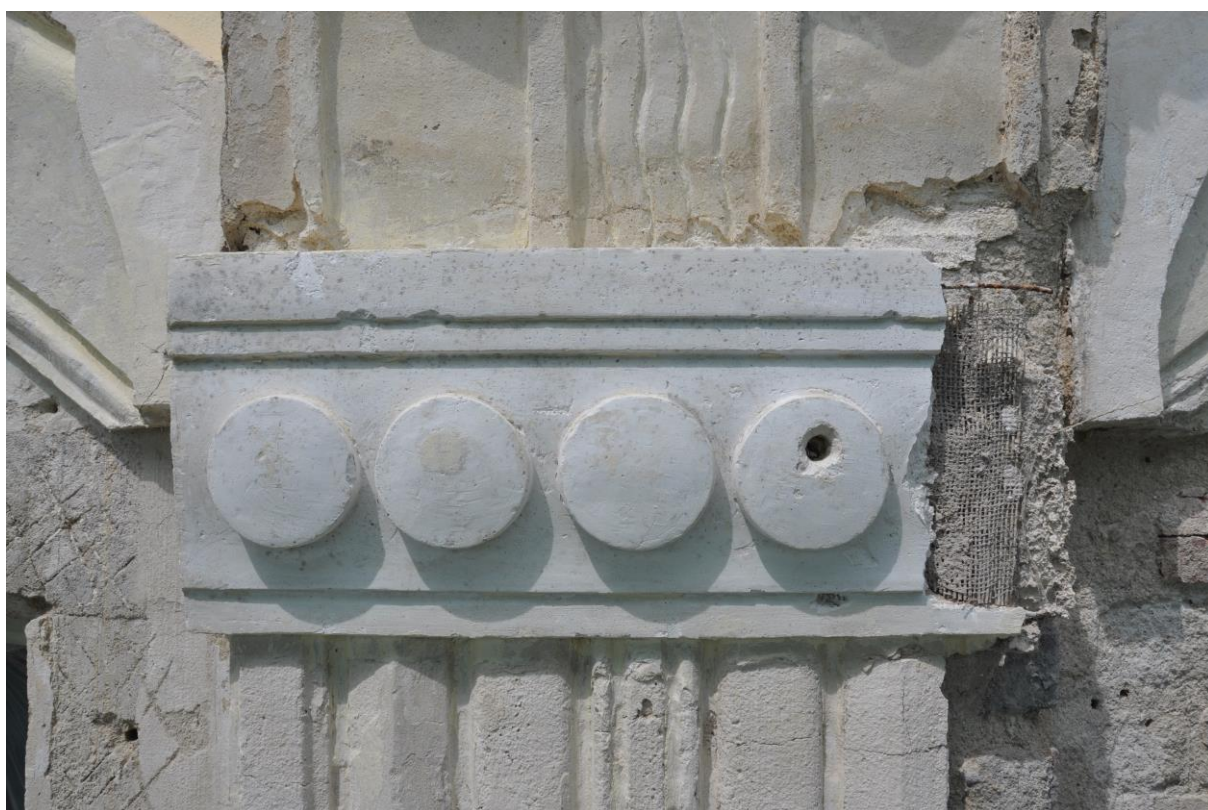
Obrázek 10 - Poškozený odlitek vyztužený rezivějícím drátem a jutou
