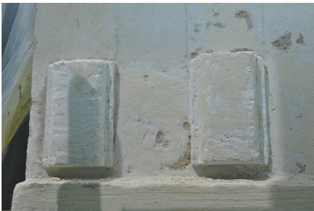
Obrázek 16 - Poškození povrchu plastických prvků po zvolení špatné metody čištění nátěrů
