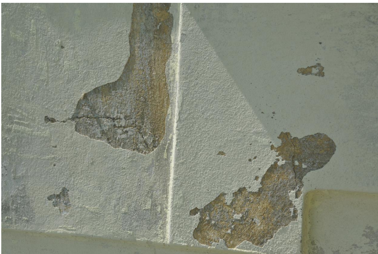
Obrázek 22 - Prosvítající původní barevnost pod štukem
