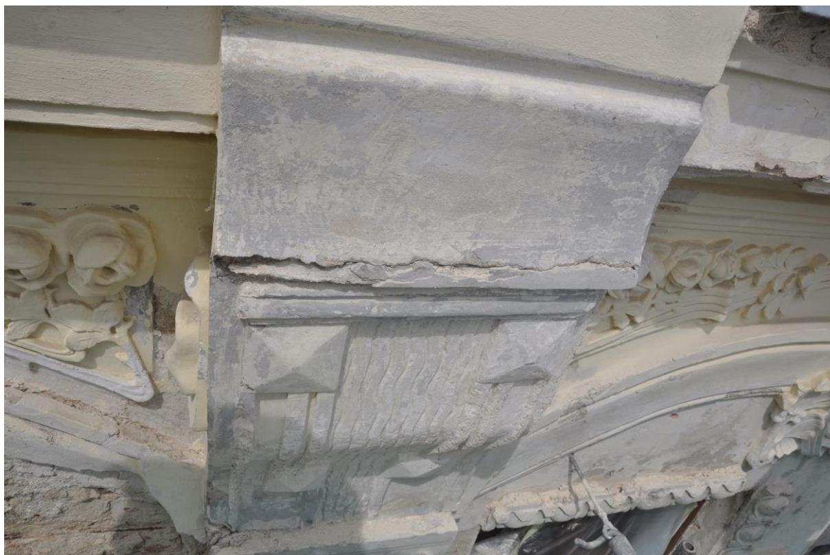
Obrázek 3 - Plastický prvek, stav po očištění
