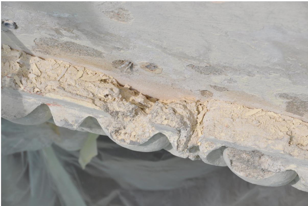
Obrázek 7 - Poškození způsobené stáním vody na vrcholu odlitku
