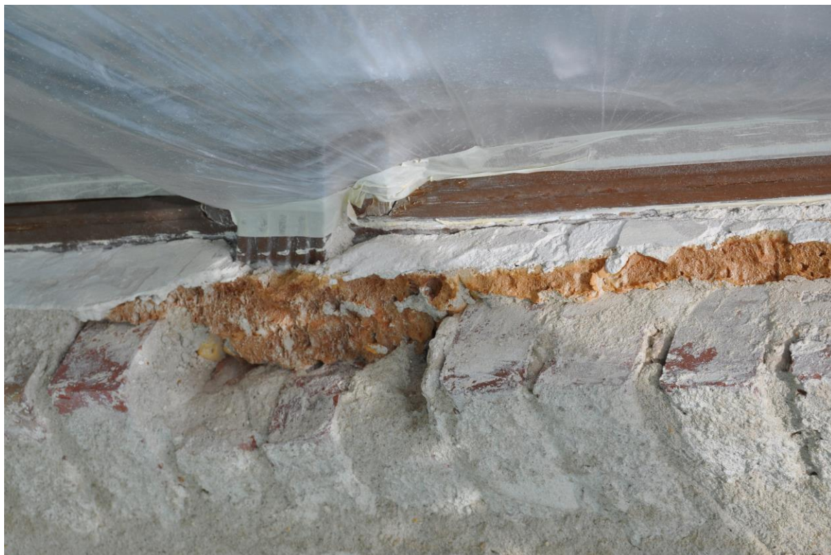
Obrázek 13 - Nadměrné množství stárnoucí PU pěny
