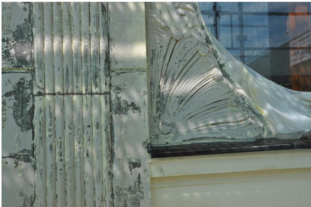
Obrázek 25 - Stav prvku po částečném očištění
