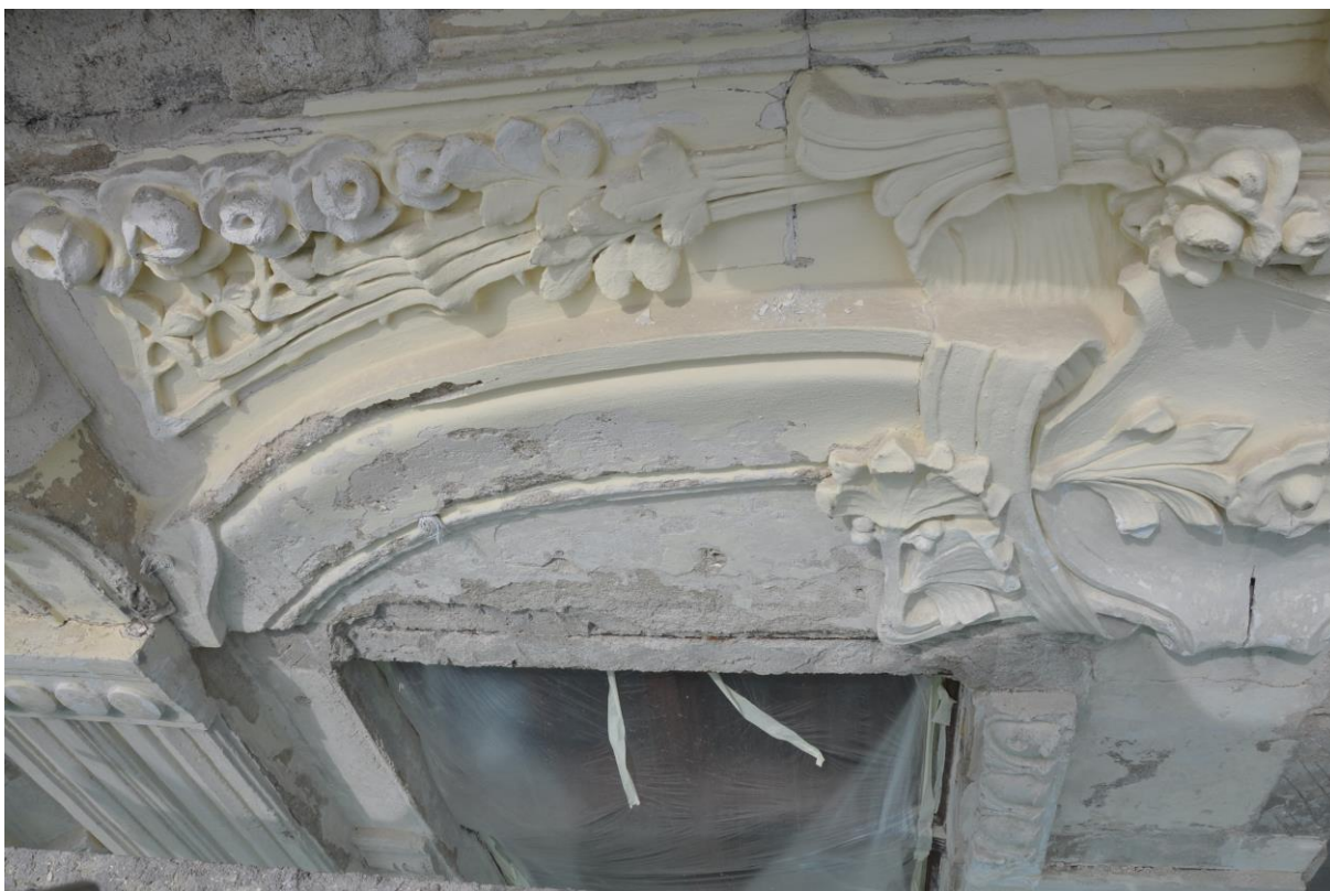
Obrázek 2 - Fotodokumentace úbytku hmoty, drobné úbytky i úbytky celých plastických celků
