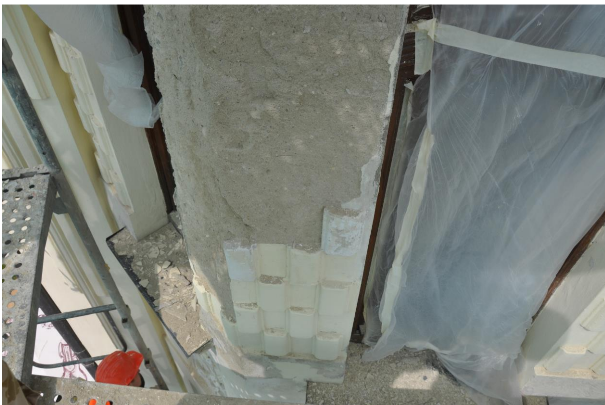
Obrázek 12 - Pískující omítka, místo po odpadlých odlítech
