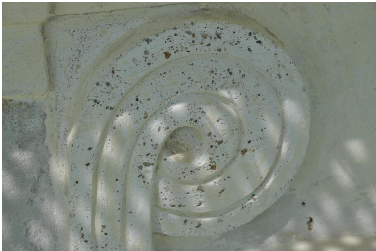
Obrázek 15 - Detail odhaleného jádra odlitků, po ztrátě nátěru a vrchní vrstvy hmoty s pojivem
