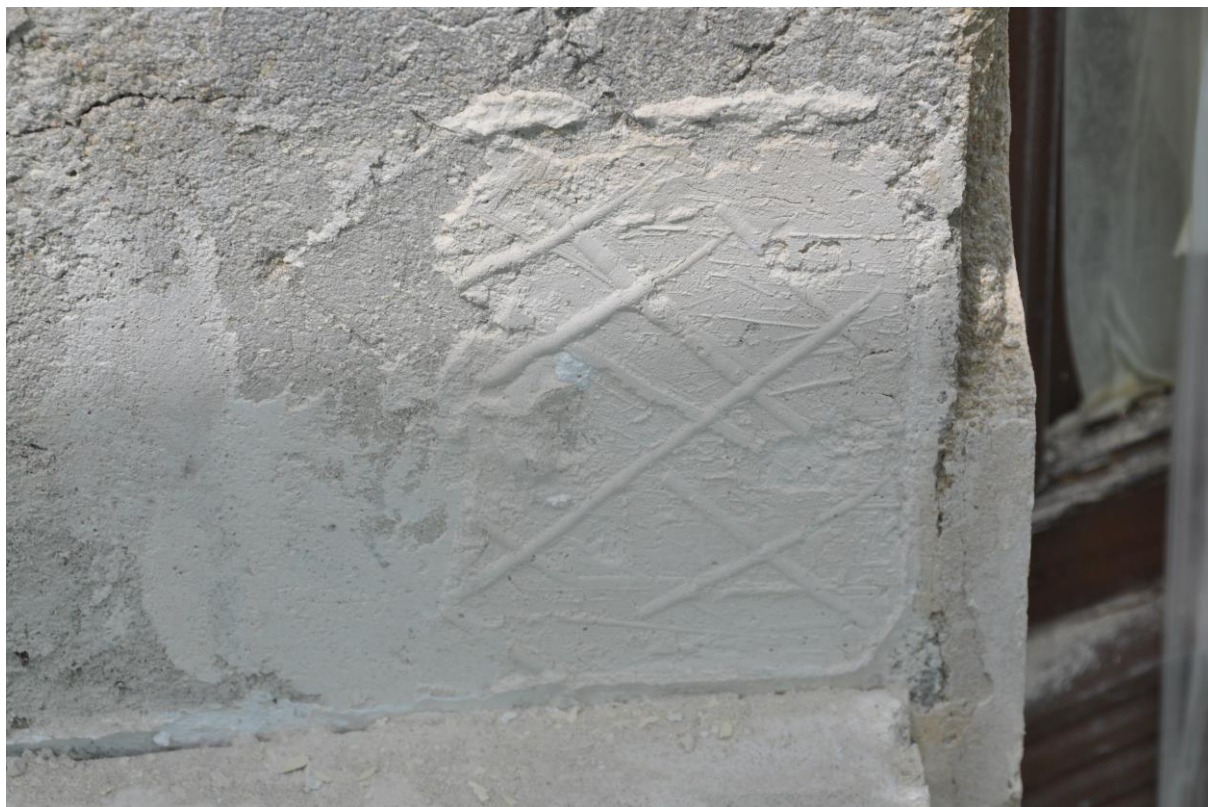
Obrázek 9 - Místo po odpadlém odlitku, patrné nedostatečné zdrsnění povrchu
