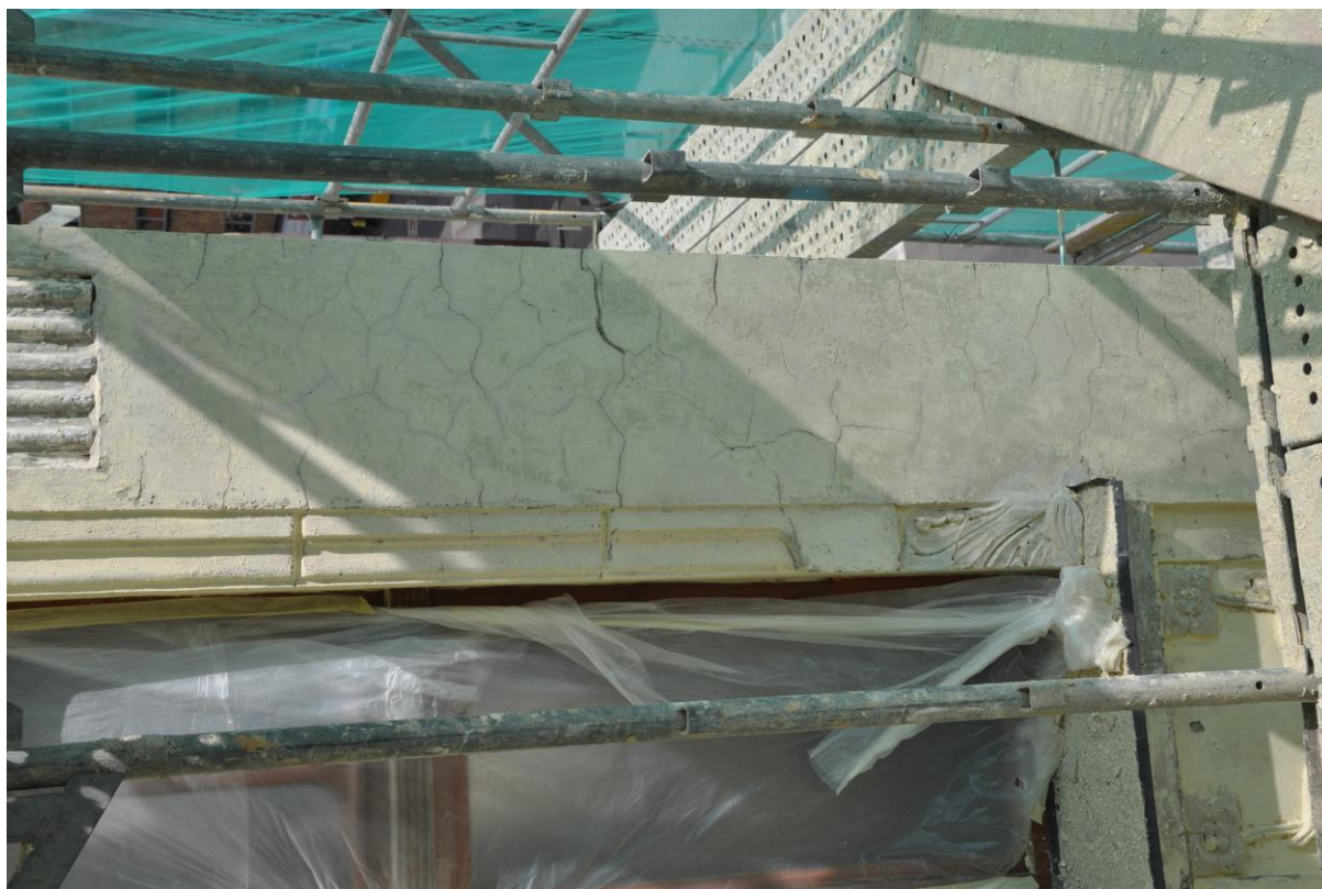
Obrázek 17 - Strukturálně dezintegrovaný pilástr
