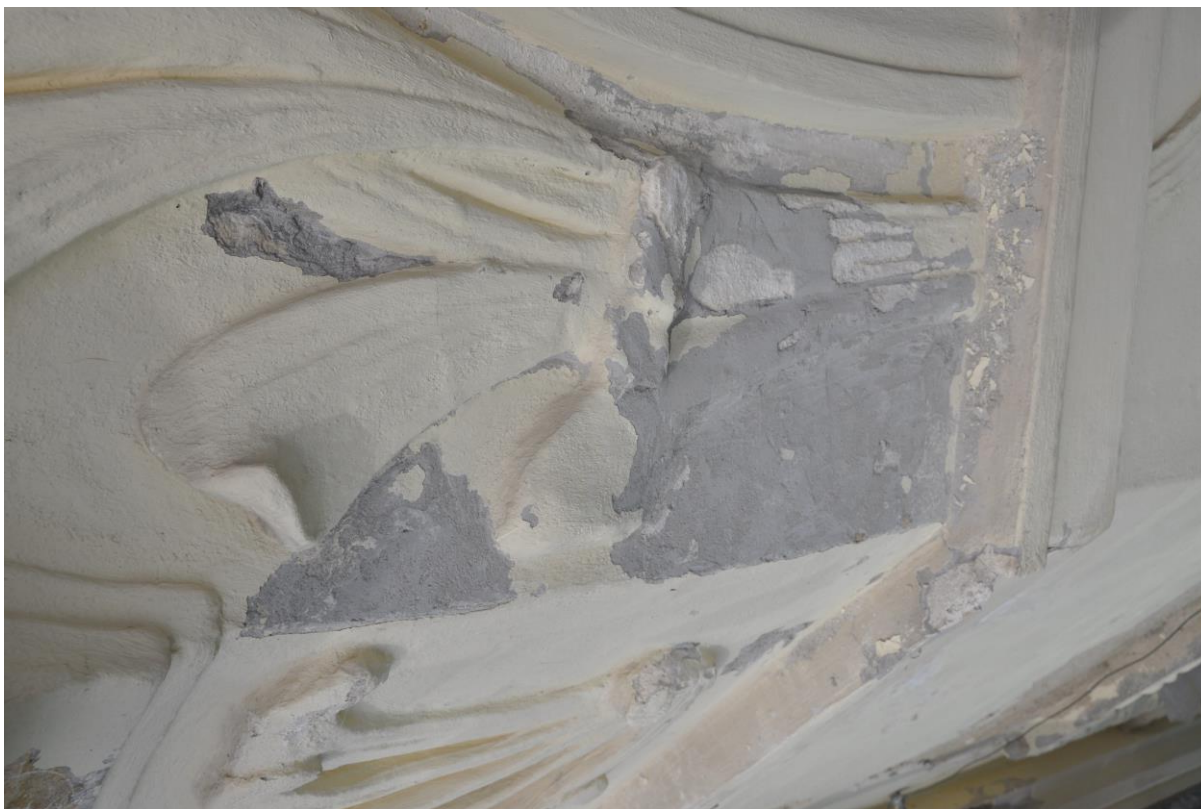
Obrázek 5 - Oprava nevhodným materiálem, který obsahuje velké množství cementu nebo flexilepidlo
