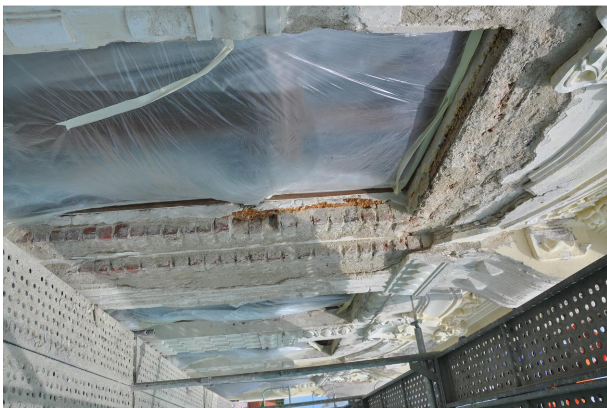
Obrázek 14 - Poškozená ostění oken
