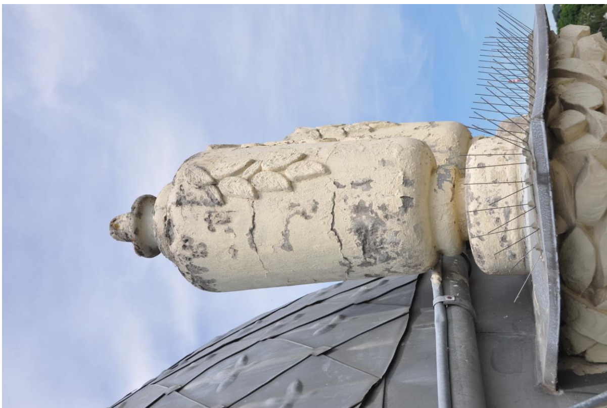
Obrázek 6 - Poškozená vrcholová váza z umělého kamene
