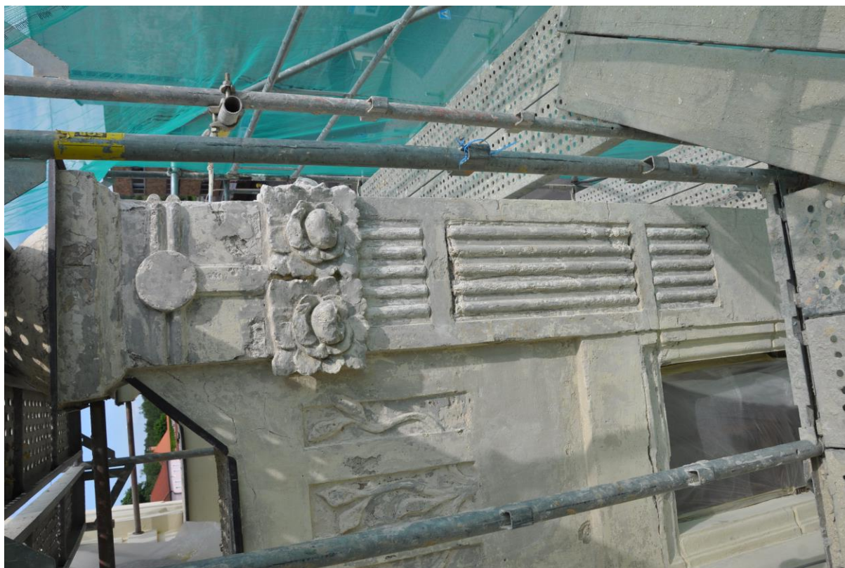
Obrázek 19 - Stav pilastru po očištění nátěrů
