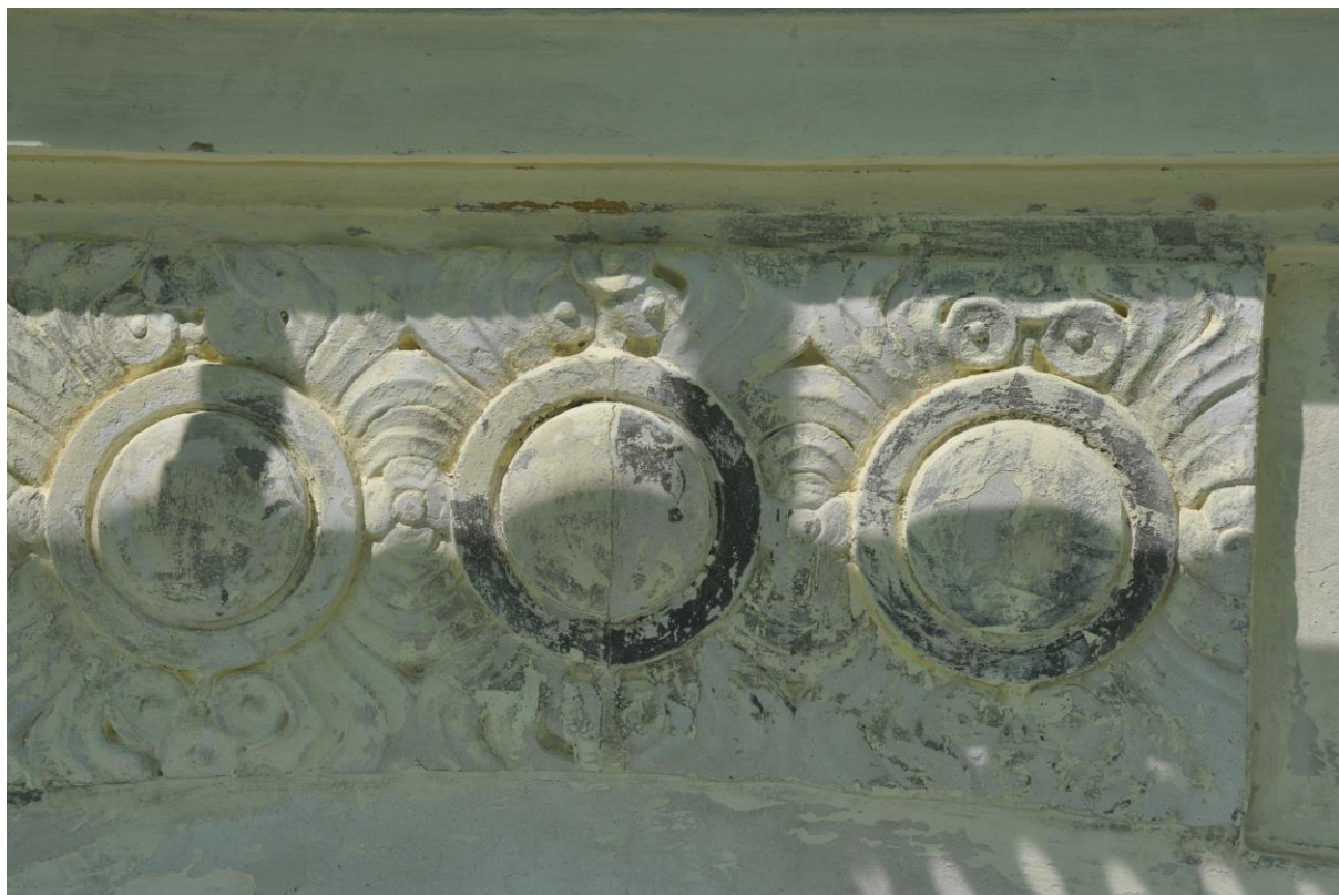
Obrázek 23 - Stav prvku po částečném očištění
