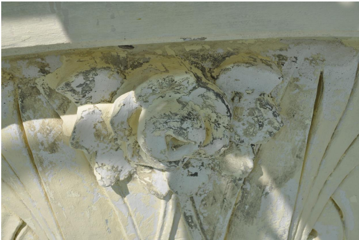
Obrázek 21 - Stav kytky po očištění části nátěru
