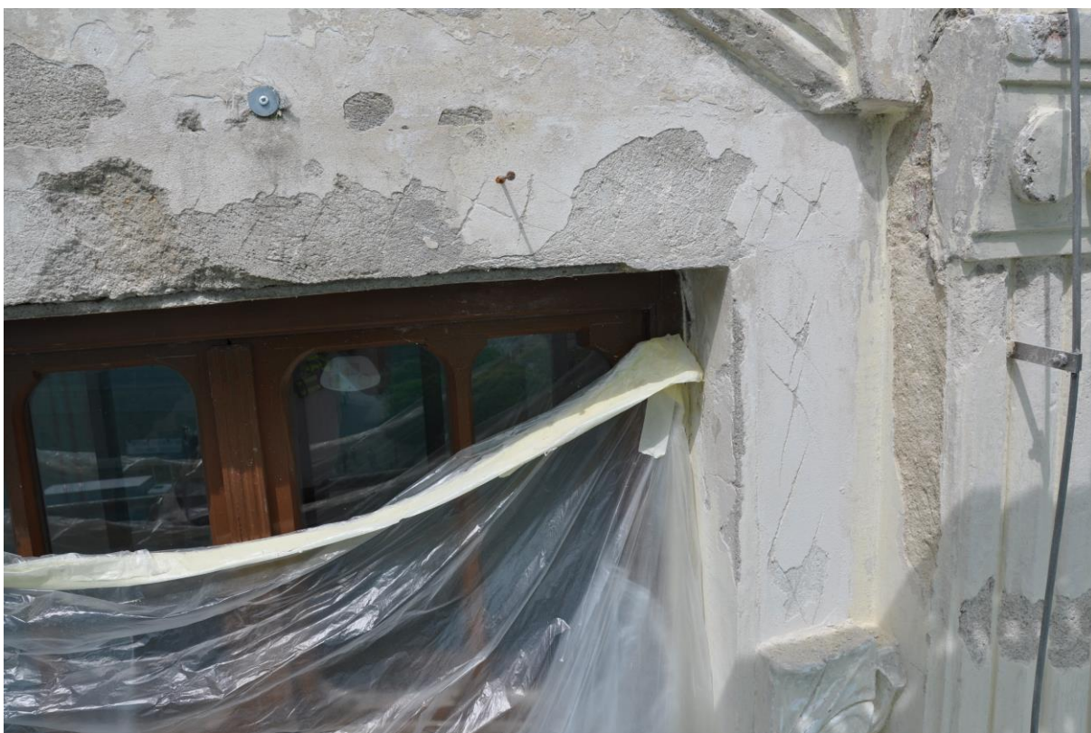
Obrázek 8 - Místa po odpadlých odlitcích vejčců, patrné nedostatečné zdrsňení povrchu a jeden kovový hřebík
