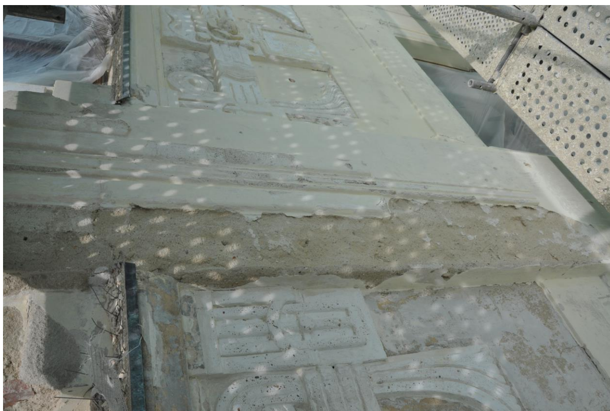
Obrázek 18 - Fotodokumentace úbytku hmoty, drobné úbytky i úbytky celých plastických celků
