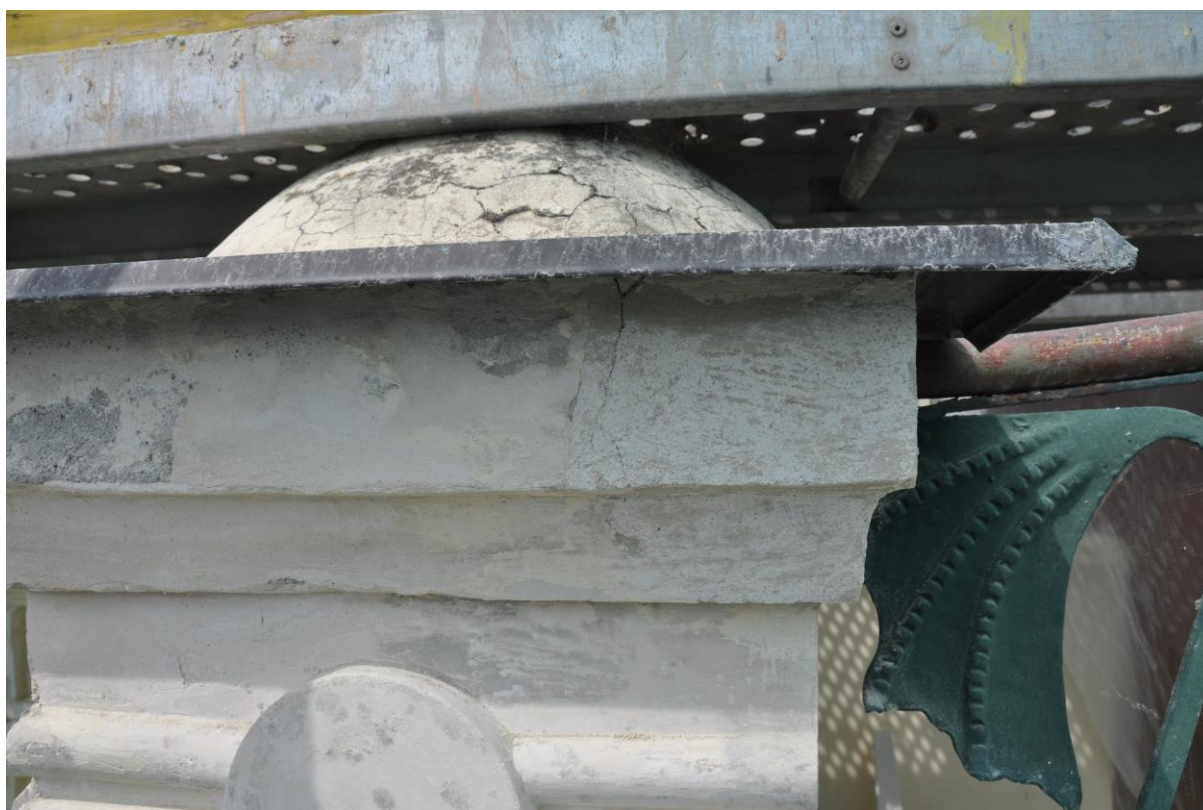
Obrázek 20 - Dezintegrace vrchní vrstvy štuky naneseného na čochce
